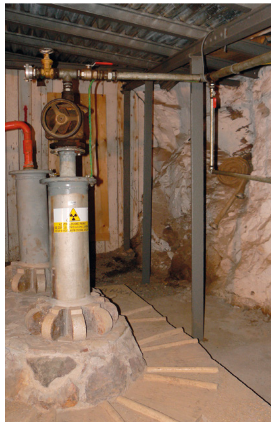
▲ Čerpání radonové vody v dole Svornost. Zdroj Flickr, autor abejorro34
